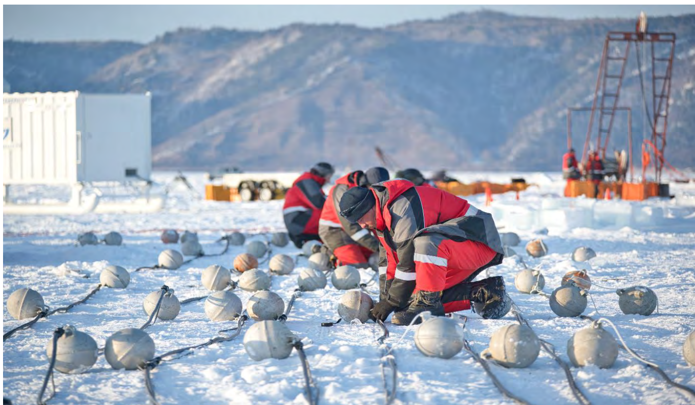
Рис. 12. Сборка гирлянды кластера установки Ваикал-GVD
