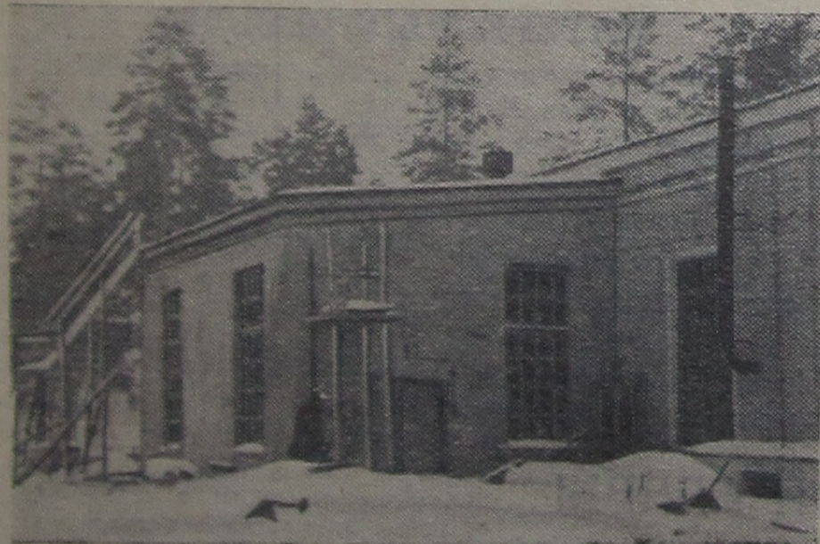
На этом снимке изображена недостроенная пристройка дополнительного помещения для компрессора к азотному заводу.
