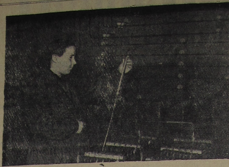
На снимке: аккумуляторщик ГЭС Раиса Григорьевна Гошева за проверкой состояния аккумуляторов. Фото Н. Печенова.
