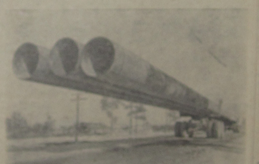
На строительстве газопровода. Фото: И. Рыбинский.
