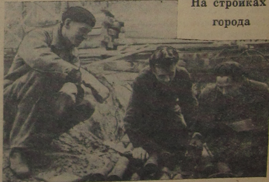
На снимке: бригадир монтажников бригады, борющейся за звание бригады коммунистического труда, В. И. Кирсанов и члены бригады А. Ф. Соловьев и Д. Д. Голубев ведут прокладку кабеля. Фото В. Баранова.
