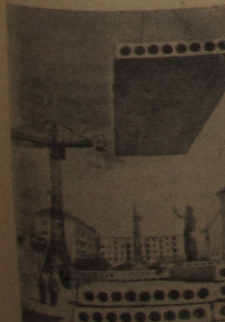
В ЗАПОРОЖЬЕ создаются новые кварталы жилых домов для металлургов, энергетиков, строителей. За семилетие намечено построить около полутора миллионов квадратных метров жилой площади. В первом полугодии этого го-
