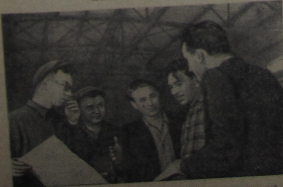
На Дрогобычском машиностроительном заводе Львовского экономического района создается поточная линия механической обработки долота № 12 для буровых установок. Для осуществле-
