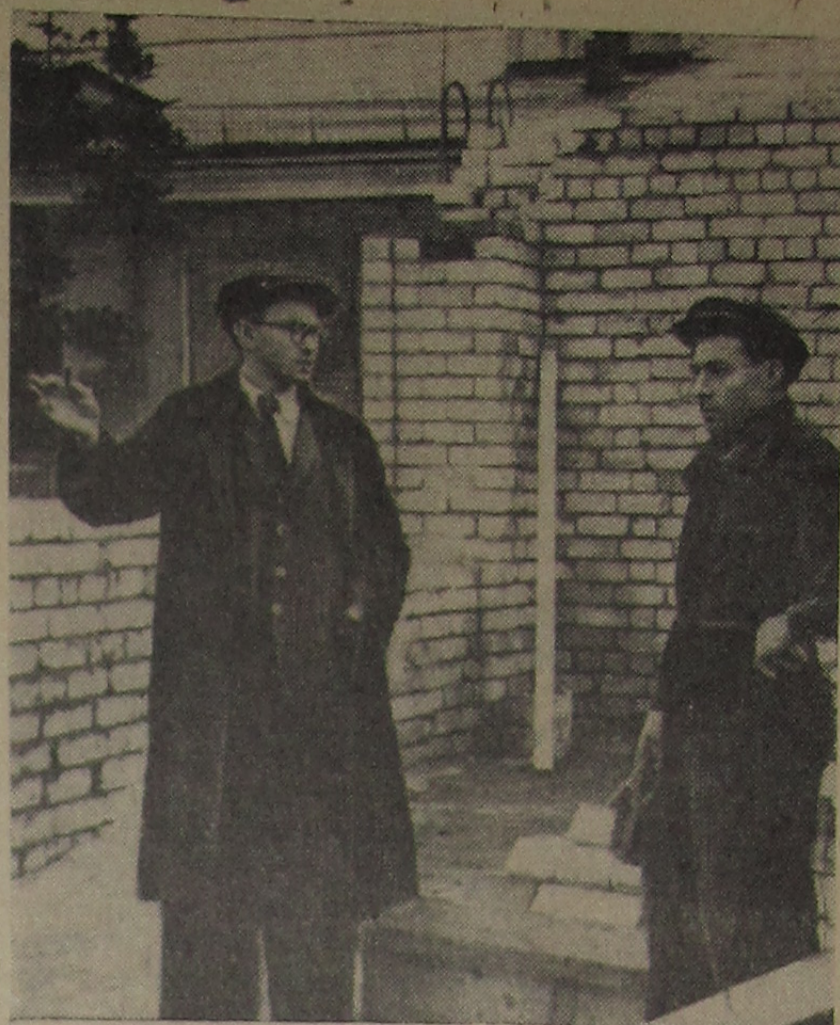
Хозрасчетная комплексная бригада коммуниста В. В. Семевского ведет строительство двух жилых домов. В одном из них скоро начнутся отделочные работы, в другом — кладка стен четвертого этажа.
