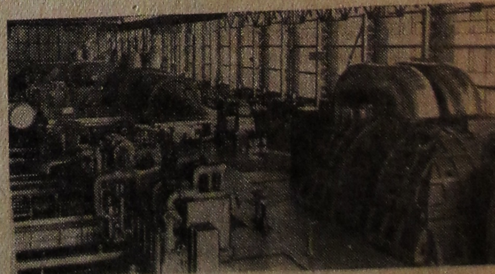
СТАЛИНСКАЯ ОБЛАСТЬ. Закончен монтаж и начато опробование еще одного турбогенератора на строящейся Старобешевской ГРЭС. Тем самым завершено сооружение первой очереди этой крупной тепловой электростанции. Ее первые агрегаты уже вырабатывают миллионы киловатт-часов электроэнергии.
