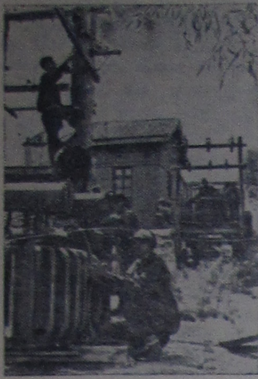
Китайская Народная Республика. Горняки Дагунского угольного месторождения в провинции Шаньси (Северный Китай) помогают крестьянам уезда Шаосянь вести работы по электрификации. Они участвуют в строительстве электростанции и проводят линии электропередач. На снимке: монтаж трансформаторов. Фото Чжау Шу-мина. Агентство Синьхуа.
