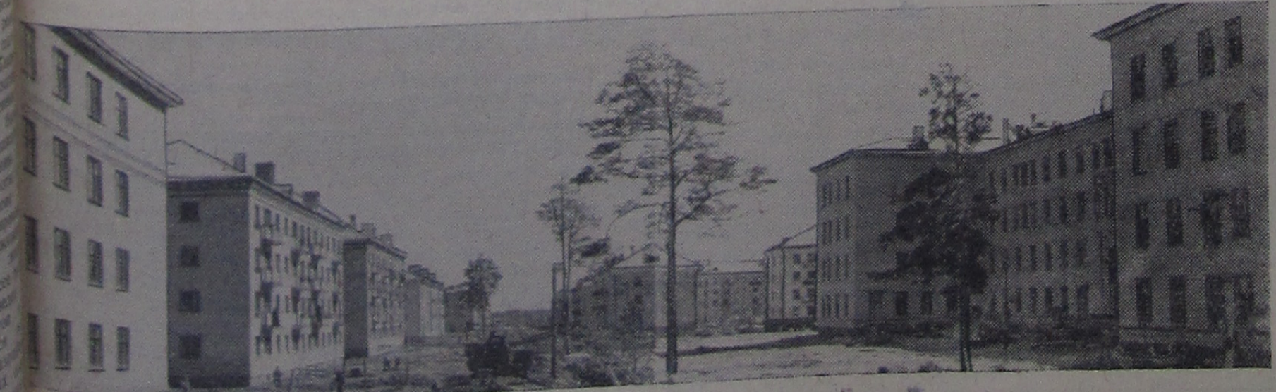
Новый строительный район Дубны. На переднем плане — больничный корпус, который будет введен в эксплуатацию в этом году.
