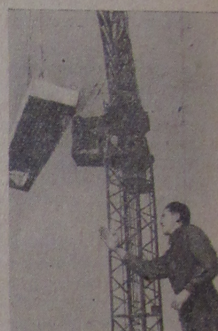
Г. Д. Красильников — бригадир комплексной бригады, успешно работающей на строительстве дома № 17 квартала г. Дубны
