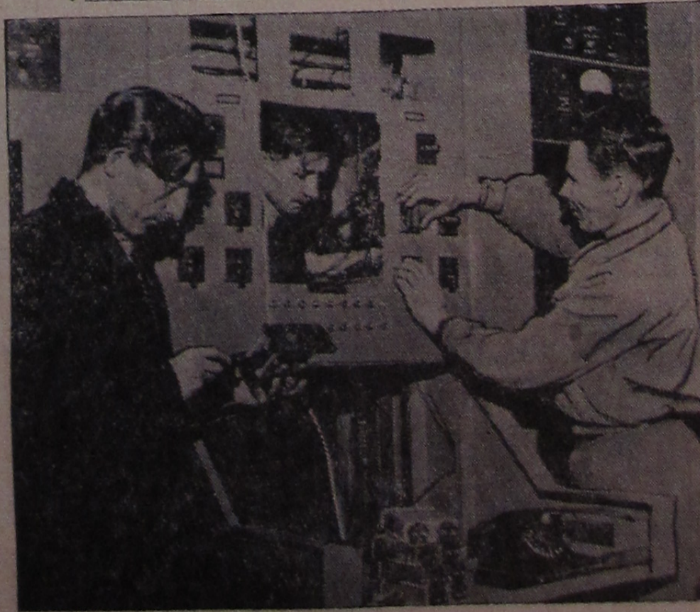
Наш фотокорреспондент В. Шустин сфотографировал хороших производственников (слева направо) Т. Кулагина, А. Крылова и Я. Панферова отлично выполнявших работы по монтажу щита управления линейного ускорителя в ЛВЭ.
