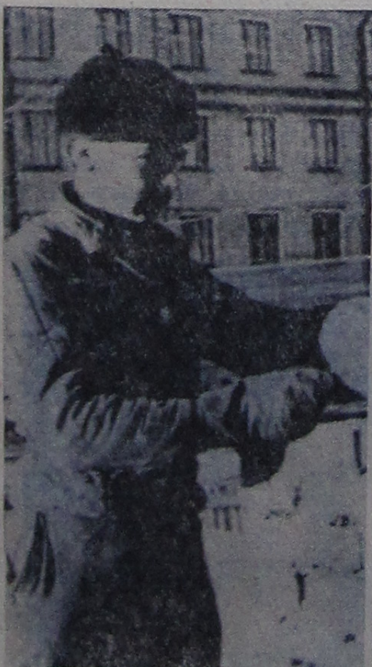
ТРЕТИЙ год трудится на стройках правобережной части города каменщик Виктор Жижко.
