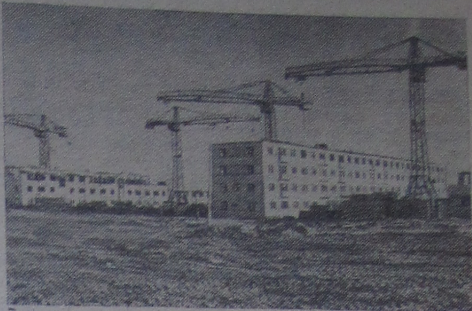
Московская область. Полным ходом идет строительство центральной усадьбы молочно-товарного совхоза «Заря коммунизма» — крупнейшего хозяйства в средней полосе России. Здесь, на 59-м километре Каширского шоссе, возводятся первые четырехэтажные 64-квартирные дома со всеми удобствами. В них будет жить около пяти тысяч тружеников сельского хозяйства. Агргород совхоза «Заря коммунизма» — населенный пункт городского типа, с современным уровнем благоустройства и передовой технологией сельскохозяйственного производства. Это прообраз советской деревни недалекого будущего. На снимке: строительство первых крупноблочных жилых домов на центральной усадьбе совхоза «Заря коммунизма». Фото О. Кузьмина. ФОТОХРОНИКА ТАСС
