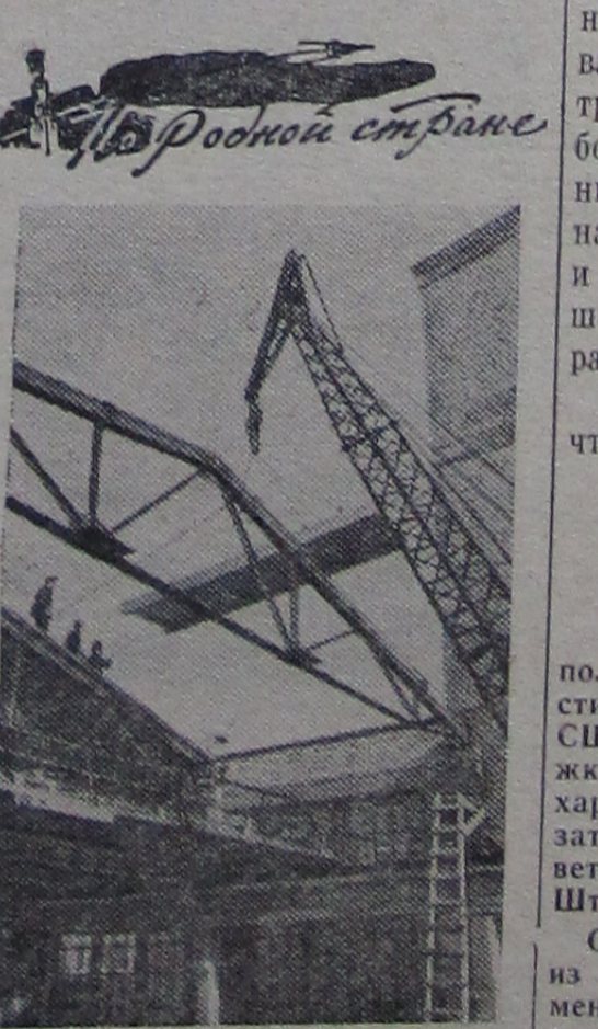
На строительной площадке, где будет воздвигнут Сыктывкарский целлюлозно-бумажный комбинат, сооружаются подсобные предприятия. На снимке: один из участков строительства бетонного завода и железобетонных конструкций комбината производственных предприятий. Фото В. Вежова. Фотохроника ТАСС
