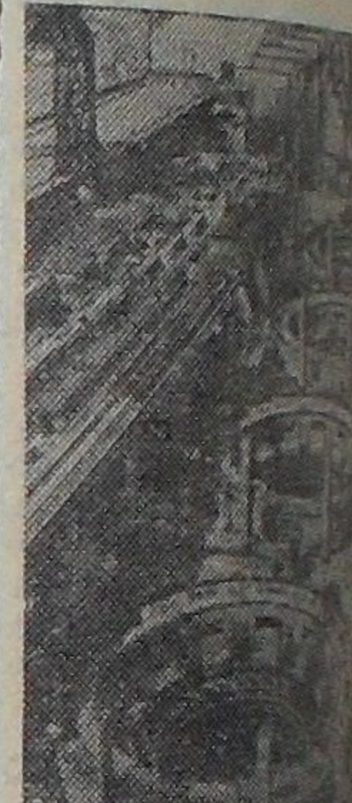
УКРАИНСКАЯ ССР. Оружие Днепродзержинского ГЭС близится к концу. Ители уже приступили к монтажу оборудования. Успешно идет подготовка к пуску Днепра. Течение притоки реки уже оставлено. Днепродзержинская строятся новыми методами. Здесь применяются сборные бетон. При бетонировании стен строители в первую очередь используют бетонные плиты. Новшества, применяемые гидростроителями, дали возможность сократить стоимость строительства ГЭС на 25 процентов против обычной. Первая очередь ГЭС введена в эксплуатацию в 1963 году. На снимке: строящийся машинный зал Днепродзержинской ГЭС. Фото А. Запары. Фотохроника ТАСС.
