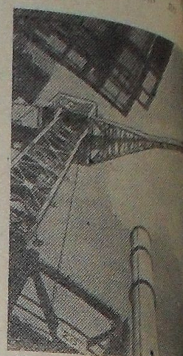
На снимке: на строительстве электростанции. Фото МТИ—ТАСС
