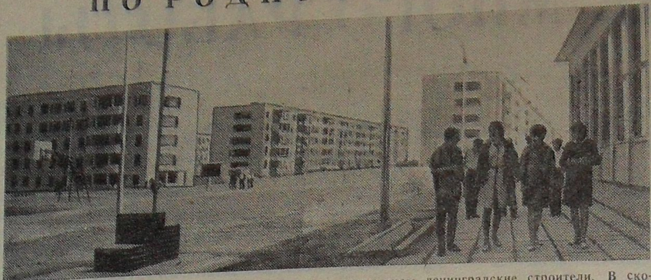
Ключи от 1.420 новых квартир вручили в этом году ташкентцам ленинградские строители. В скором времени будут сданы в эксплуатацию еще 1.378 квартир, детский сад на 280 мест и школа. За отличные показатели в работе многие ленинградцы награждены значком «Строитель Ташкента». На снимке: новые дома на Чиланзаре, построенные ленинградцами. Фото Р. Шамсутдинова.
