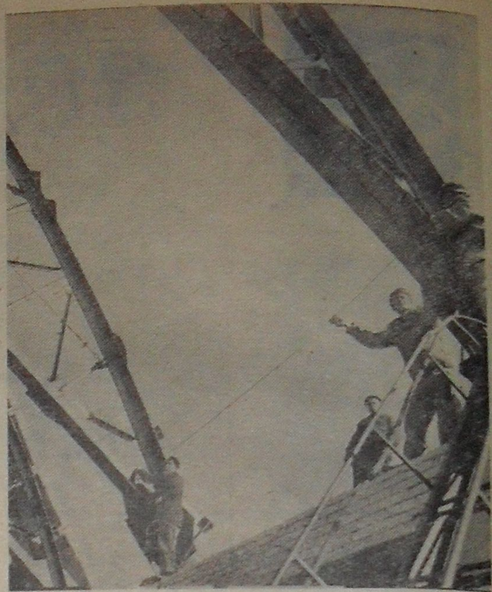
Монтаж последней фермы на бассейне.
