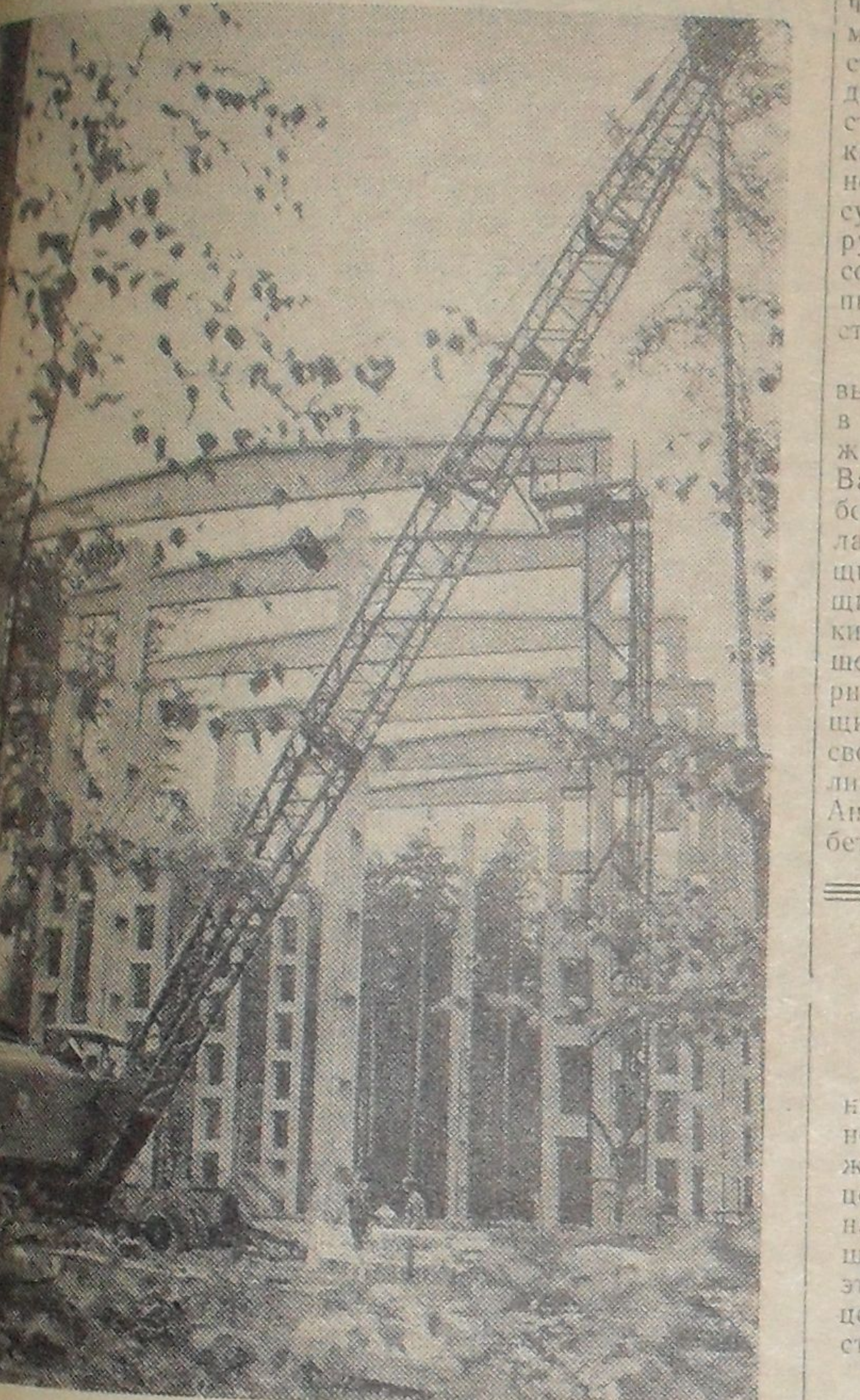
На строительстве криогенного корпуса Лаборатории высоких энергий. Фото Ю. Туманова.
