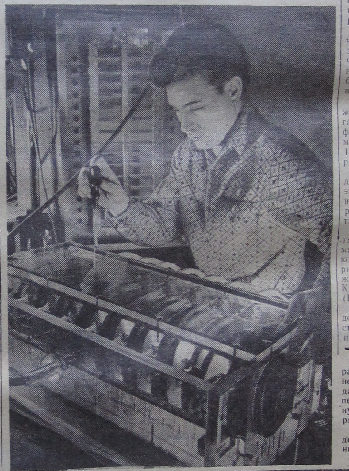
На снимке: механик Н. М. Доров готовит генератор к испытаниям.
