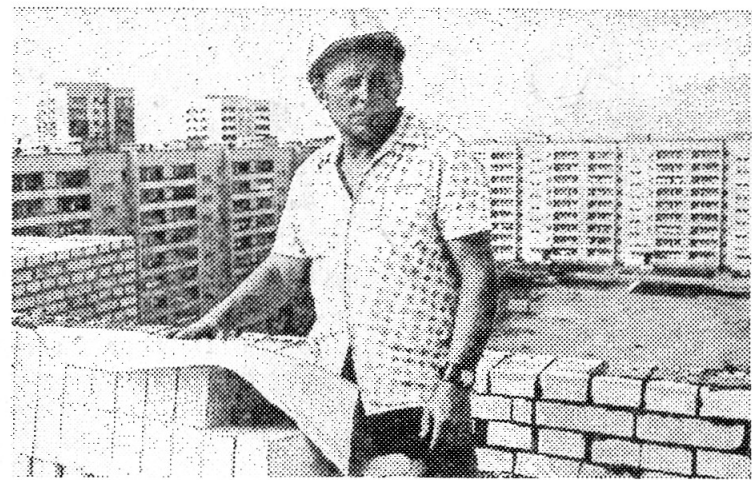
На снимке: бригадир подрядной бригады Алексей Александрович Цветков. Сейчас бригада ведет строительство 143-квартирного девятиэтажного жилого дома в квартале 22. Это уже третий жилой дом, который возводит бригада А. А. Цветкова по методу бригадного подряда.
