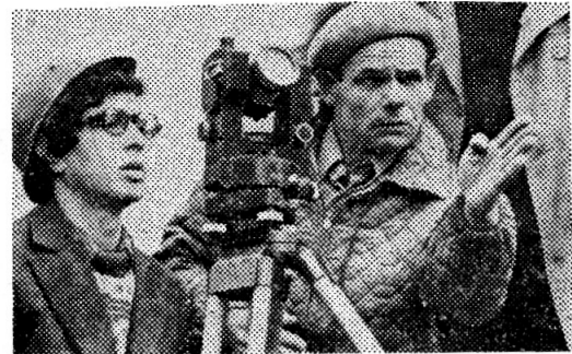
Ведущий конструктор по подъему и осадке трубы Ю. Телешев дает указания геодезистам во время контрольной проверки установки трубы.
