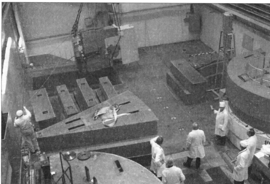
Демонтированная откатная защита отправляется в хранилище
