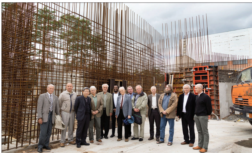
Члены ПКК по ядерной физике на строительной площадке нового корпуса ЛЯР.
