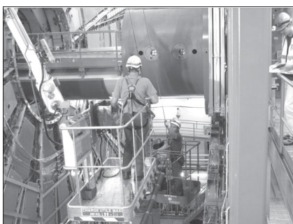
Монтаж последних модулей на глубине 100 метров.
