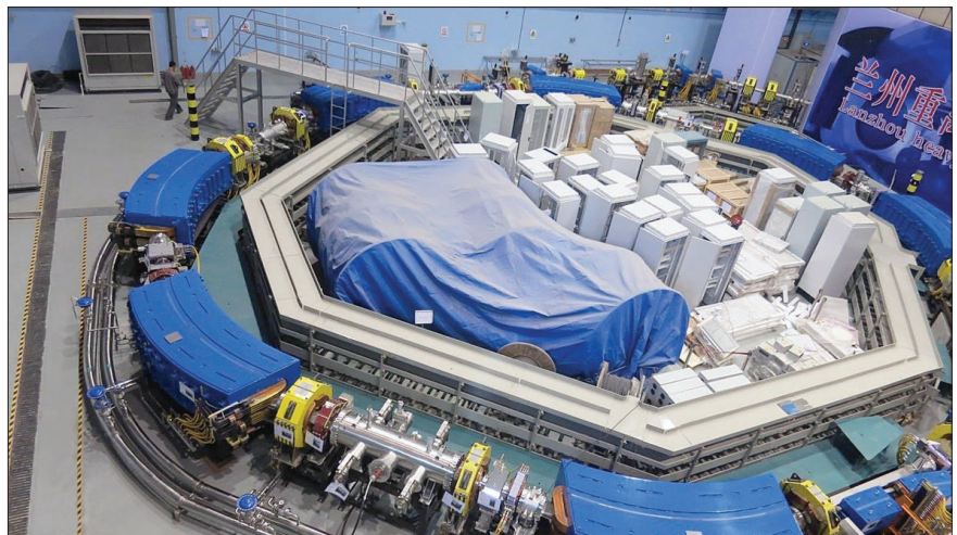
Медицинский ускоритель в пригороде Ланьчжоу: завершение строительства.
