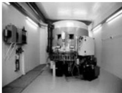
Рис. 22. Внешний вид CYCLONE18/9. Насосы и другое оборудование размещены под магнитом
