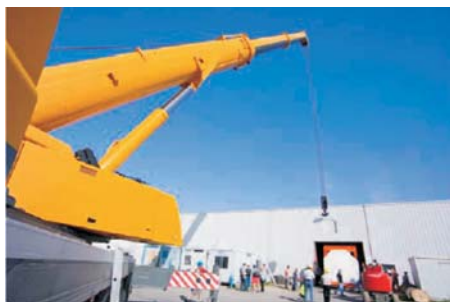
Рис. 34. Перенос детектора к входу в шахту
