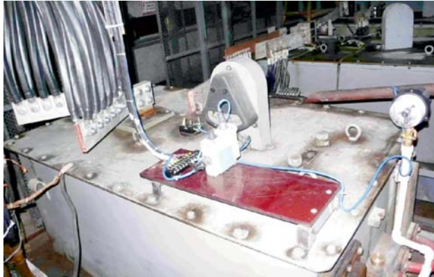
Рис. 6.1. Масляный шунт ШМ 6кА-2В
