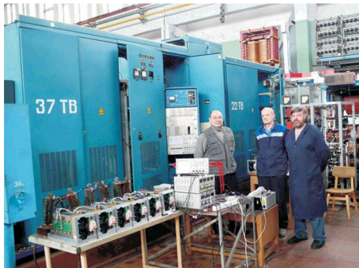
Рис. 3.5. Тиристорный выпрямитель 37ТВ и регулятор тока 80 В × 300 А (машинный зал корп. 1А, март 2013 г.)
