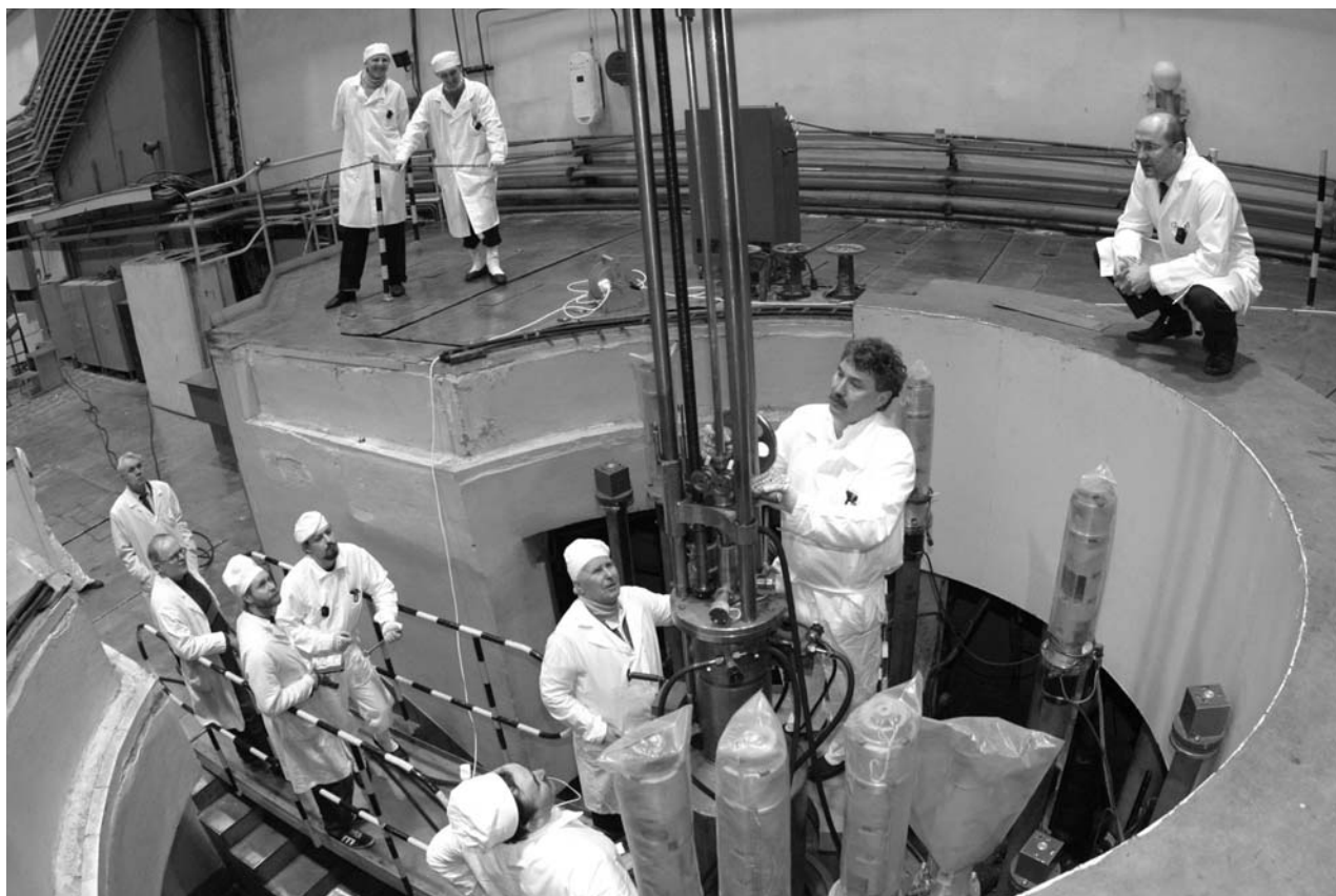
Лаборатория нейтронной физики им. И. М. Франка, март. Работы по разгрузке активной зоны реактора ИБР-2
