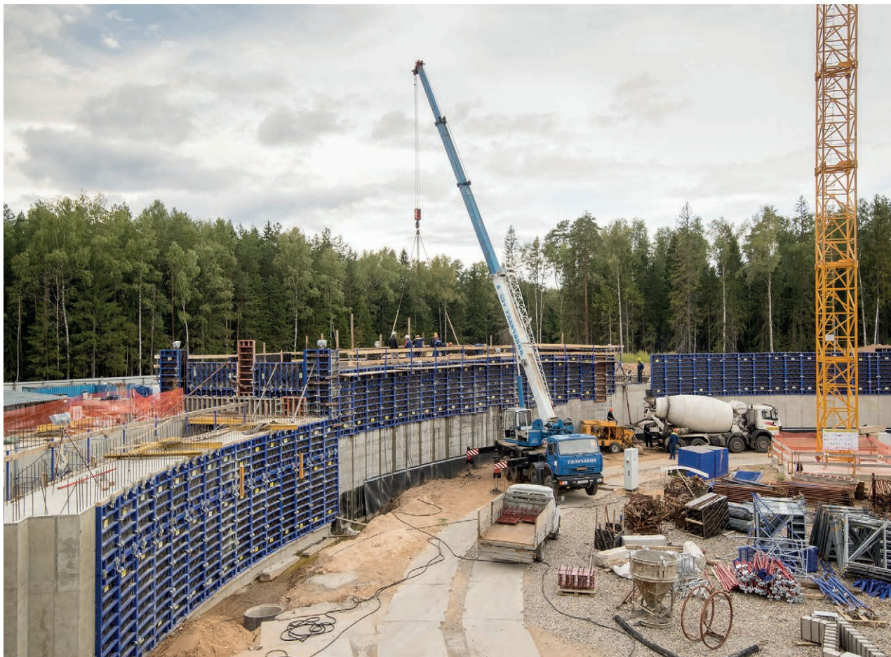
Строительство коллайдера NICA
