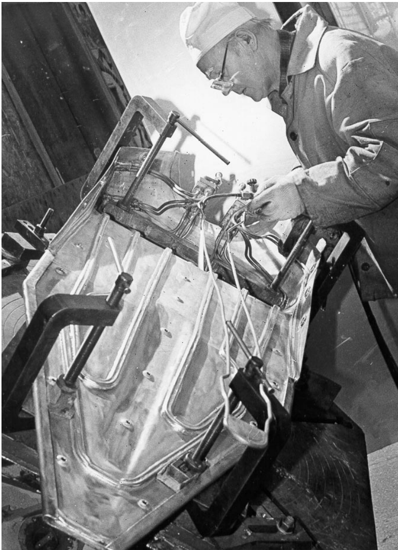
Опытное производство. Монтаж оборудования по циклотронному проекту ИЯН ВИНЧА (Белград, Югославия)
