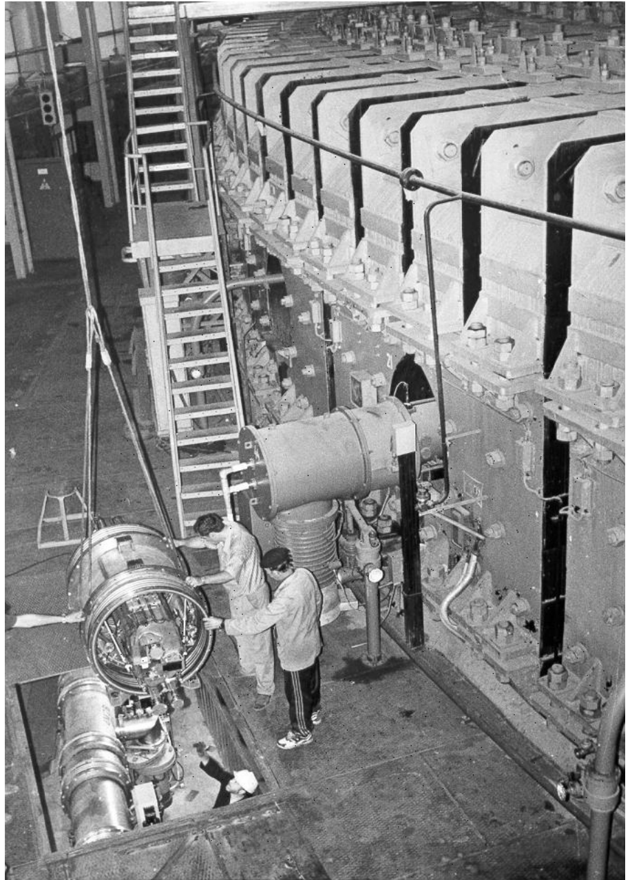
Лаборатория высоких энергий. Завершение сборки участка кольца нуклотрона с элементами системы медленного вывода пучка заряженных частиц
