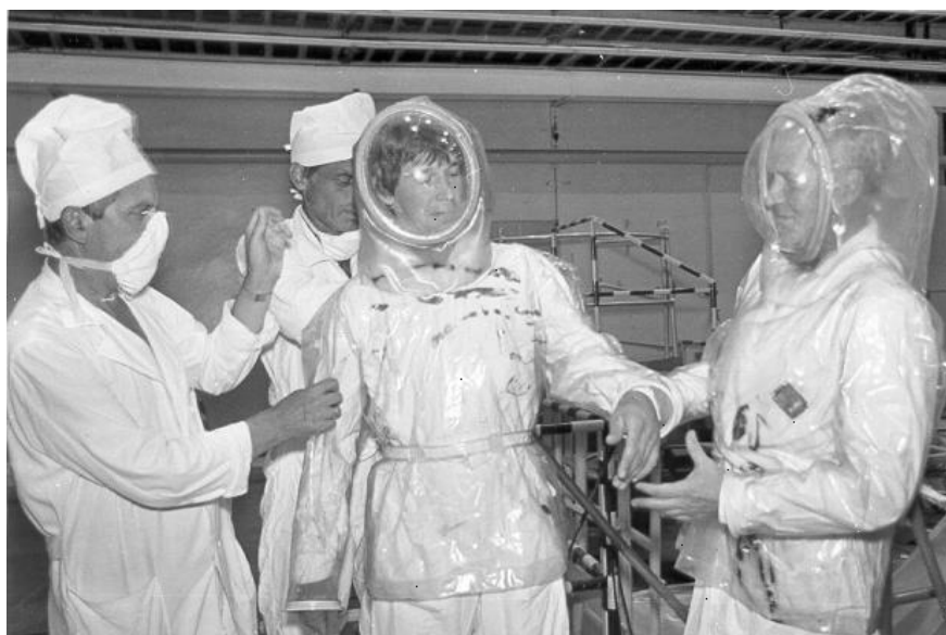
Лаборатория нейтронной физики им. И.М.Франка. Подготовка пневмокостюмов для проведения работ по разделке старого подвижного отражателя реактора ИБР-2 при помощи безопасного взрыва
